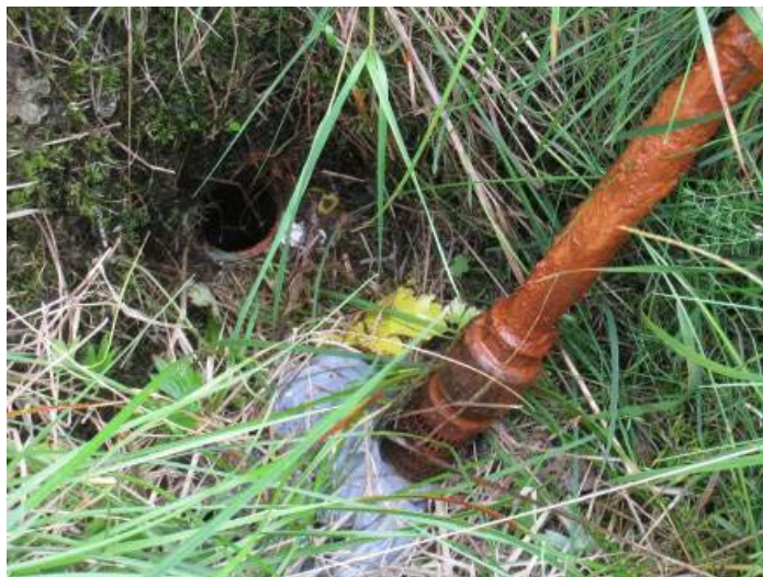
Mynd 2: Dæla við árbakka Bjallalækjar í landi Lækjarsels. Efnahvarfasetið járnnoxíð hefur safnast saman á dælunni í gegnum tíðina.
