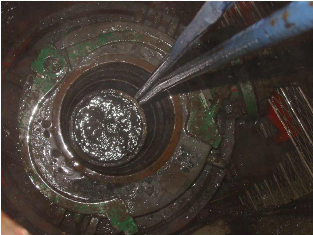
Séð ofan á fóðringu, þar sem sýnt er hvernig strengur er settur niður á milli fóðringa. (mynd Sighvatur Ellefsen)
