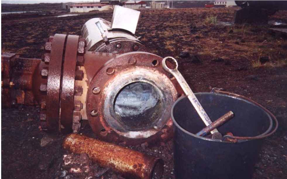
Mynd 11. Mynd tekin fyrir blendu af um 5 mm þykkum útfellingum; aðallega blýglans, eirkís og leir, vottur af pyrrhottí. Sýni 20– 22 í töflu 11.
