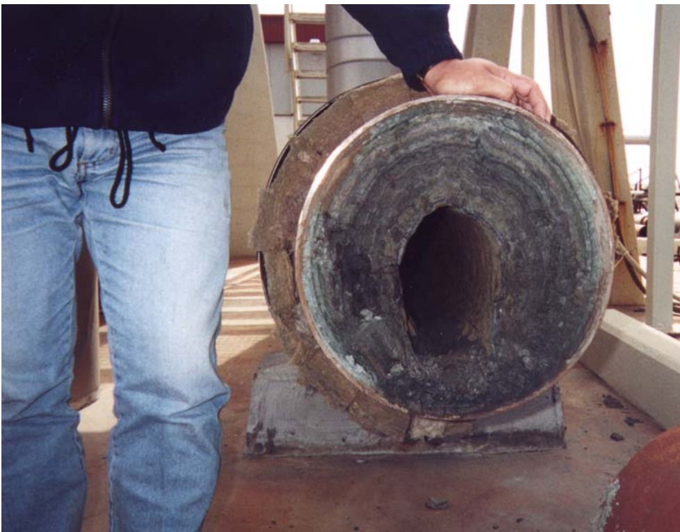
Mynd 16. Útfellingar við skiljustöð, sjólögn frá jöfnunargeymi. Niðurstöður XRD-greiningar í töflu 11
