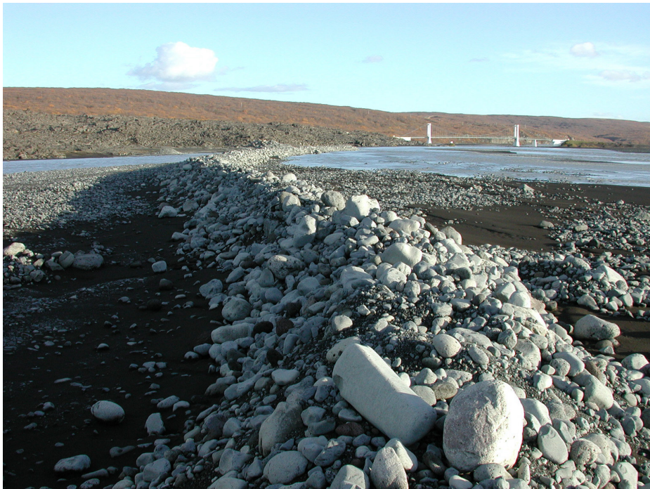
Mynd 11. Varnargarðurur við upptök Sandár, rétt neðan Jökulsárbrúar.
