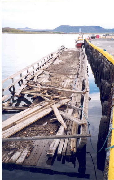
Mynd 4. Brúin sigldi til hafs án þess að valda skemmdum á leið sinni niður Sandá og Brunná og var síðan dregin að bryggju á Kópaskeri. Mynd tekin 1999.
