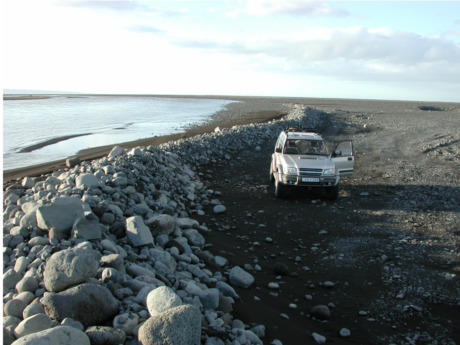
Mynd 12. Varnargarðurinn er einfaldur en hefur gerir sitt gagn. Hann var styrktur eftir að Sandárbrúna tók af 1999. Myndir 8-12 voru teknar haustið 2000. GÓF tók allar ljósmyndirnar í skýrslunni.
