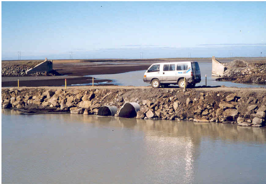
Mynd 5. Ræsi var notað til að leysa umferðarvandann um hríð, þar til ný og traustari brú hafði verið byggð yfir Sandá. Mynd tekin 1999.
