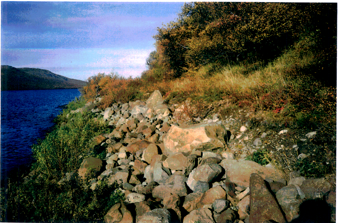
Ljósmynd 2: Í Fitjahlíð milli bústaða nr. 68a og 82. Dæmigerð uppýtt grjótvörn, sem hefur verið ýtt upp að rofbakka úr jökulruðningi. Lúpína hefur náð fótfestu í fjöruborðinu.
