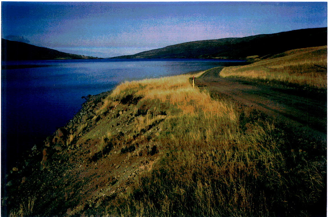
Ljósmynd 4: Bakki næst utan við Háafell. Efnið í bakkanum er jökulárset sem er mun lausara í sér en jökulruðningur. Aðeins tæpa 2 m vantar uppá að rofkanturinn nái veginum. Í fjöruborðinu er grjótvörn. Bakkinn er ekki í jafnvægi og varla hægt að treysta á að grjótvörnin nægi ef vatnsborð fer eins hátt og hæst hefur orðið. Vegurinn gæti því verið í hættu á þessum stað.
