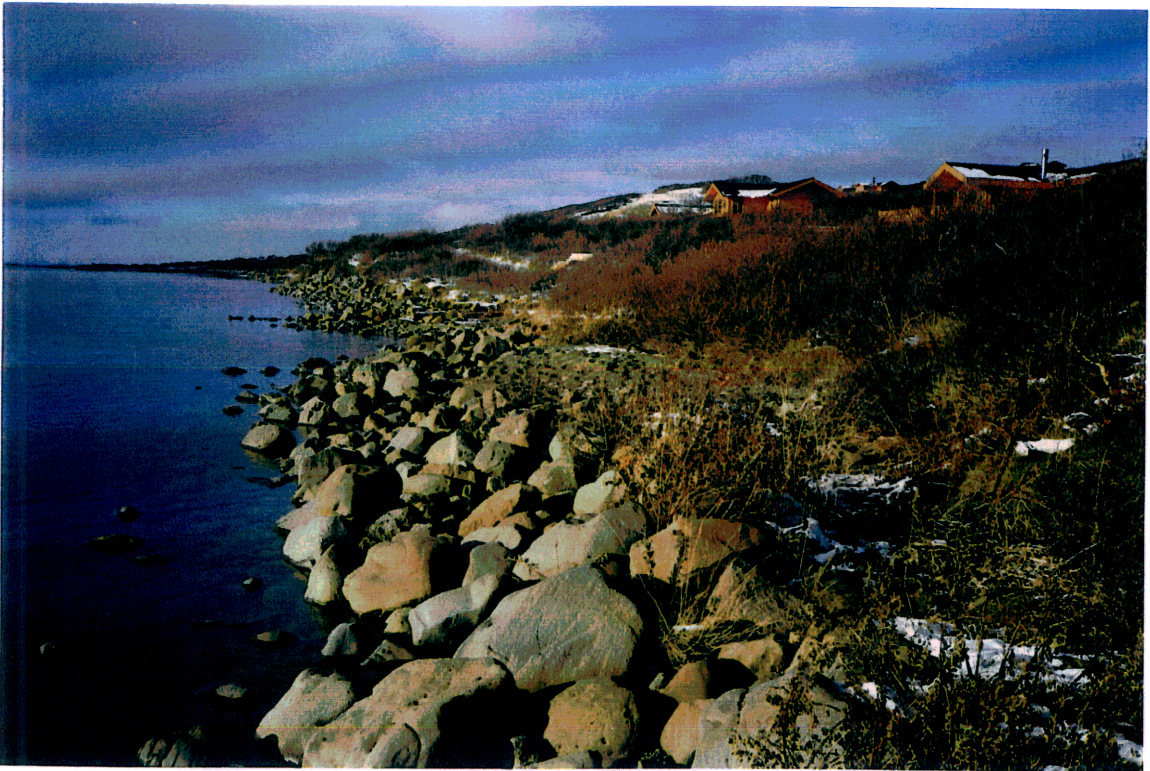
Ljósmynd 11: Í landi Vatnsenda. Myndin tekin út dalinn. Á þessum kafla er samfelld grjótvörn upp að rofbakka úr jökulruðningi. Mölin ofan við grjótvörnina sýnir hve hátt áhrifa vatnsins gætir í stórviðrum.
