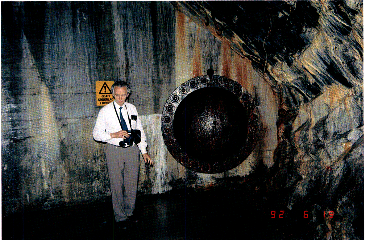
Ljósmynd 5. Steyputappi á aðrennslisgöngum K4 virkjunarinnar í Tafjord.
