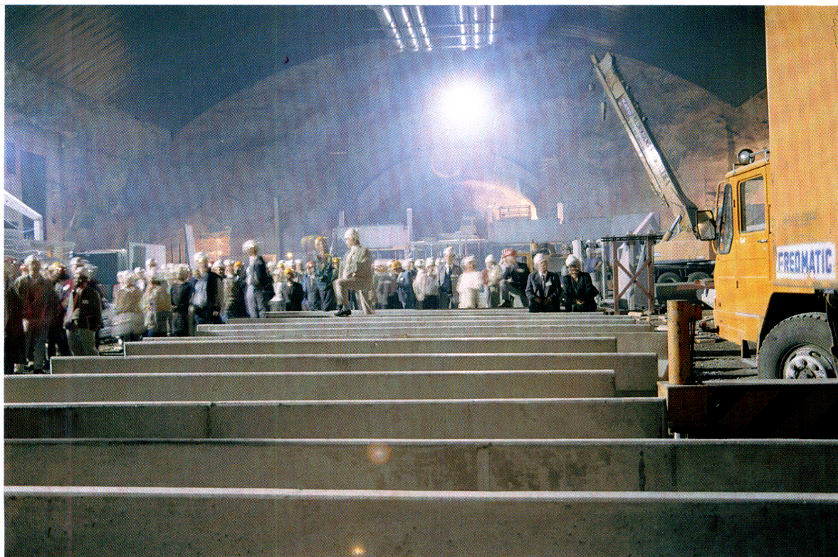
Ljósmynd 1. Íshokksleikvangurinn í Gjövik sem er verið að byggja fyrir Olympíuleikana í Lillehammer '94. Þetta er breiðasti manngerði hellir í heimi, um 50 m breiður.
