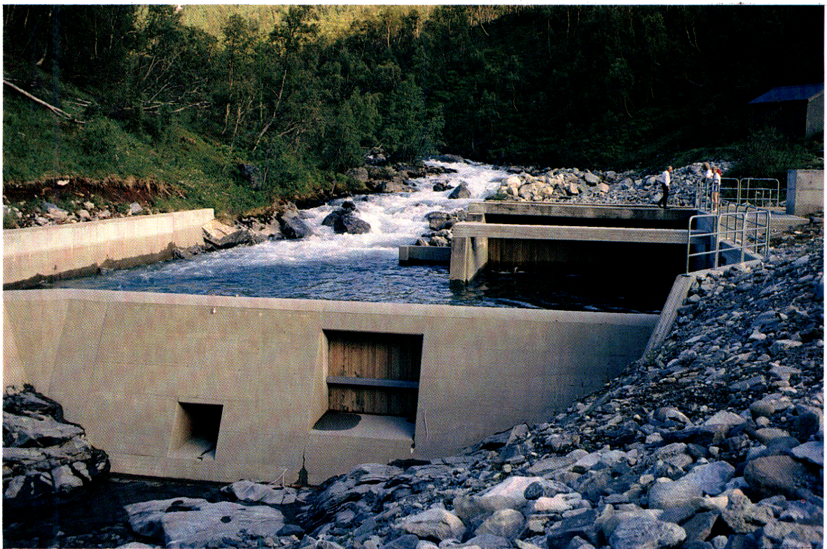
Ljósmynd 4. Lækjarinntak við K4 vatnsorkuverið í Muldal í Tafjord. Nýja stíflan er með nýrri lokugerð á botnrás.
