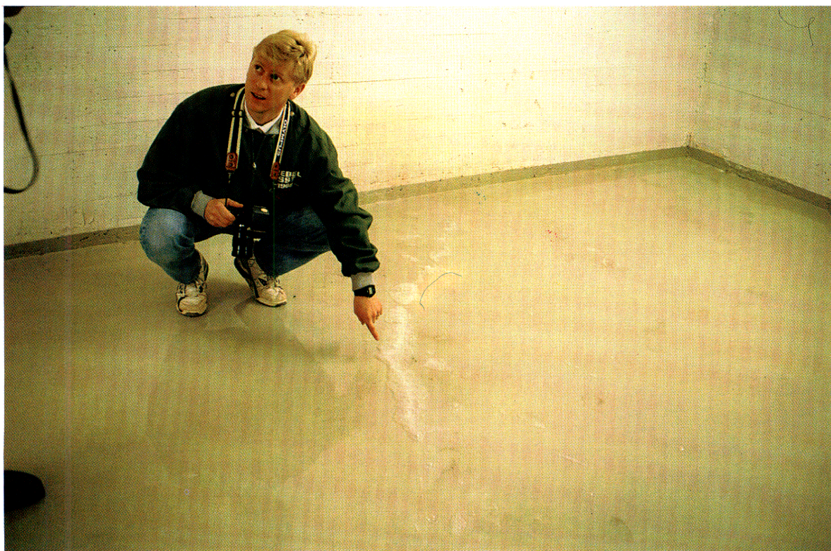
Ljósmynd 2. Leki úr loftpúða sem notaður er til að halda undirvatni Pelton-hverfla niðri. Loftpúðinn er í K5 vatnsorkuverinu í Tafjord.
