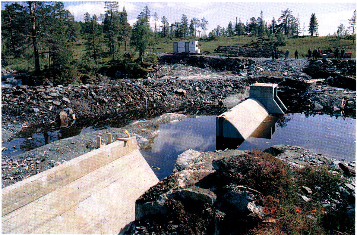
Ljósmynd 8. Lækjarinntak í byggingu við Meráker virkjunina. Inntakið er af gerð tvö.
