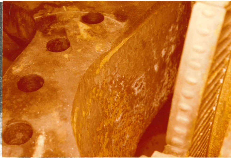
Mynd 13: Séð niður með hjóli í útblásturshús (steypustál).
