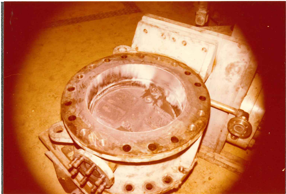
Mynd 49: Stjórnloki háþrýstigufu (útstreymismegin).
