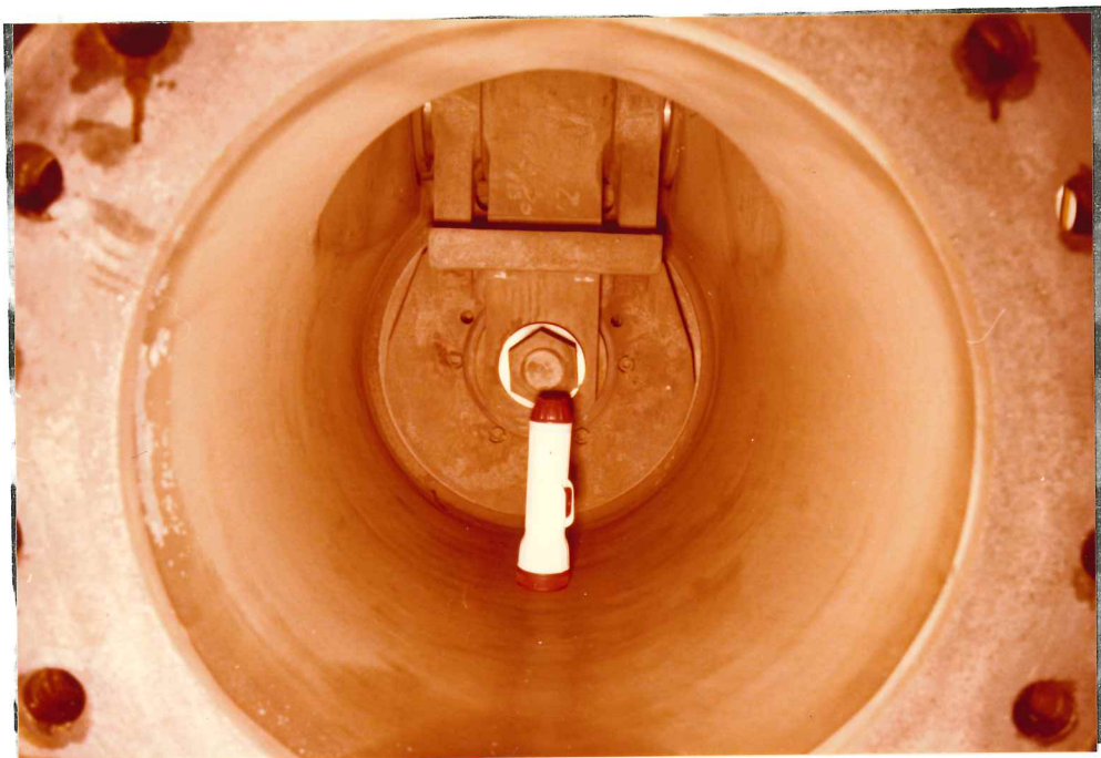
Mynd 45: Séð innstreymismegin inn í háþrýstigufuneyðarloka.
