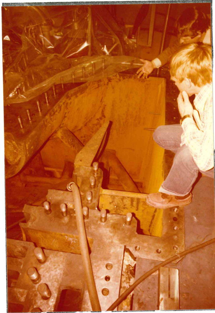
Mynd 109: Séð ofan í útblásturshús hverfils. Eimsvali fyrir neðan.
