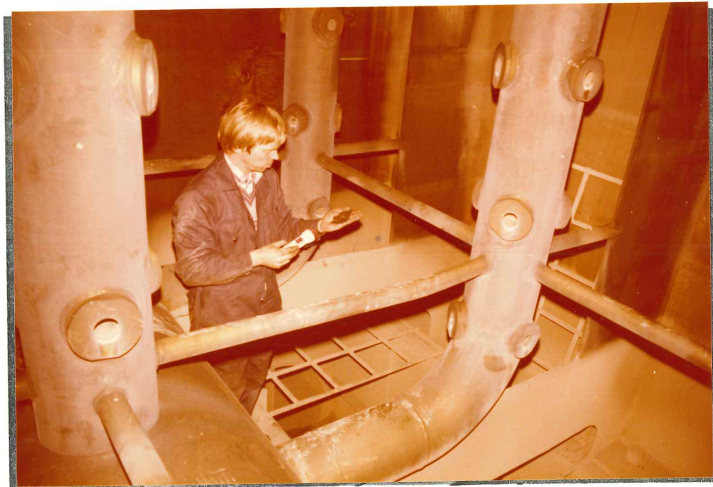
Mynd 112: Tekin voru sýni af aðskotaefni (svartar flögur) í soghólfum fyrir dælur (undir grindum).
