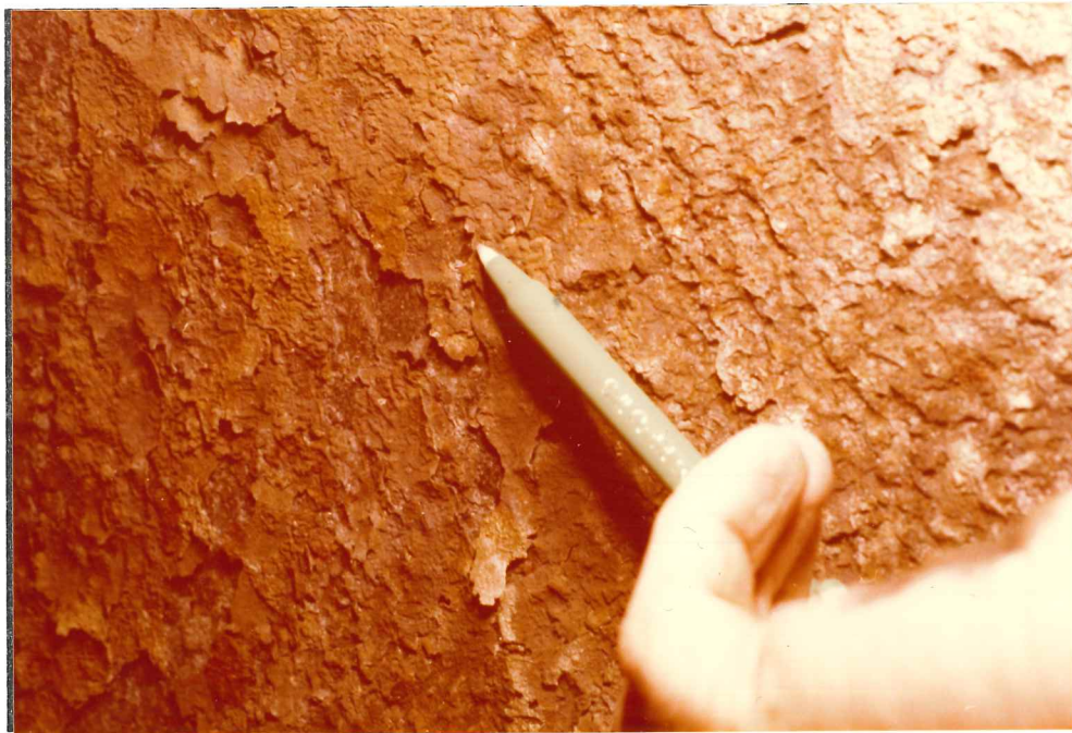
Mynd 44: Nærmynd af lágbrýstigufusíuhúsi.
