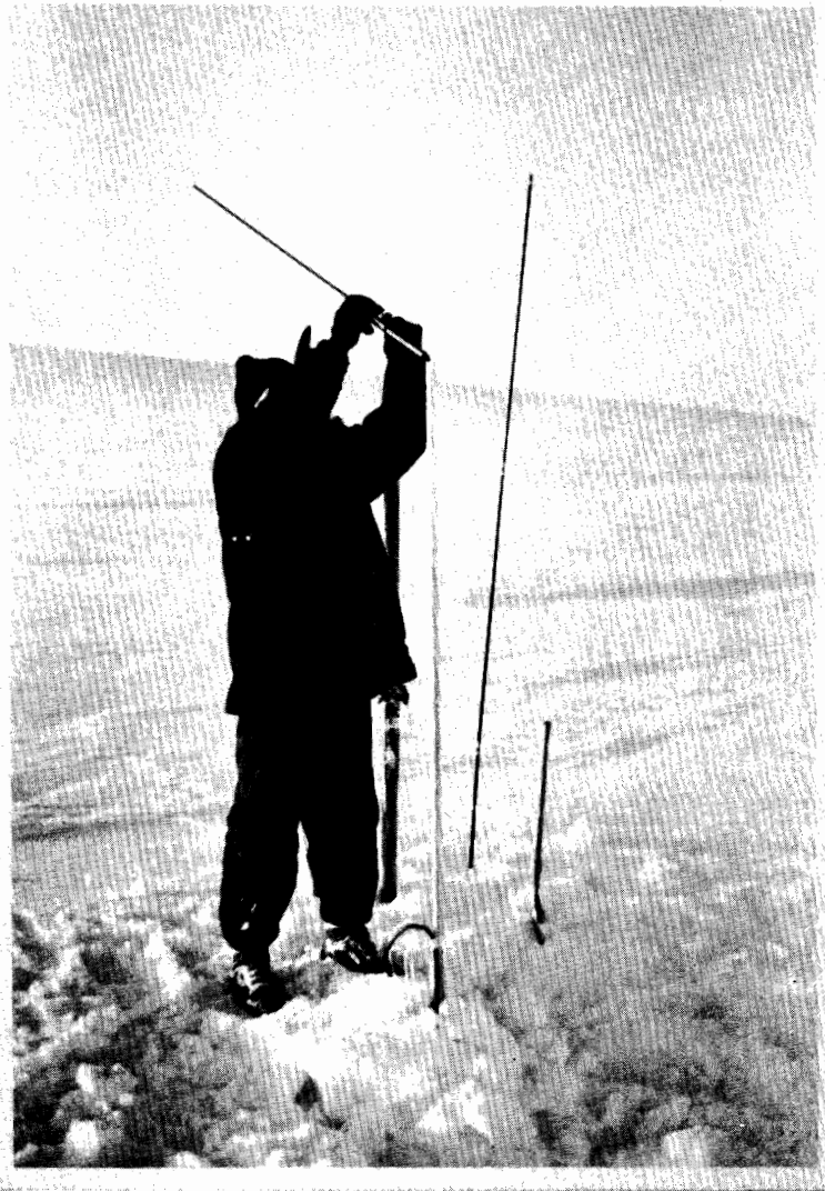
Øverst: Fra akkumulasjonsmålingene i mars 1964 da et fly for første gang landet på Ålfotbreen. Nederst: Akkumulasjonsstakene skjøtes. Merk termistor-kabler som er festet til staken. Den tynne staven er en stålsonde (for måling av mindre snødyp)
