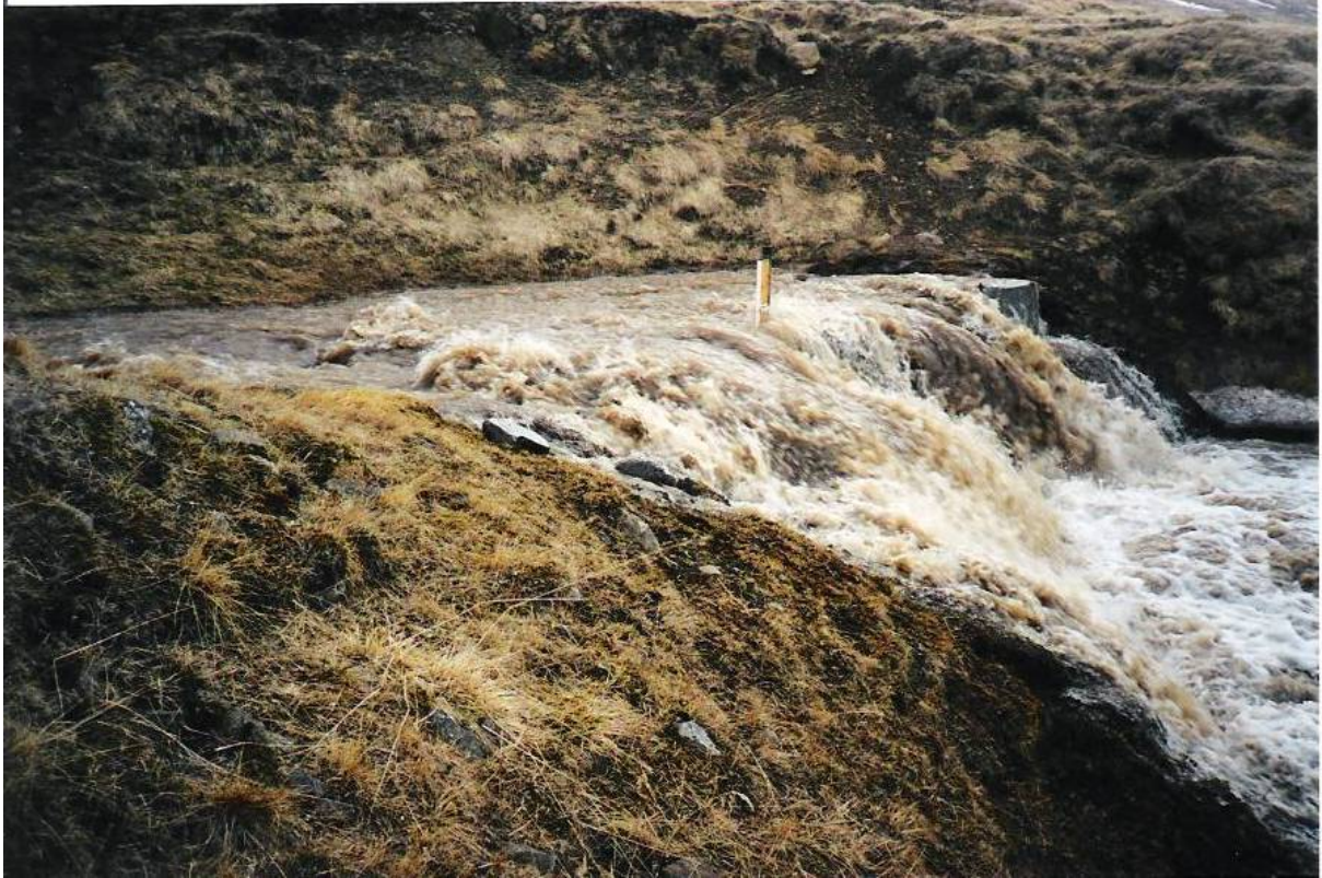
V2933 Þetta er Ytrilækur neðst. Stórt vorflóð stendur yfirog sést nánast ekkert í stífluna. Í þessu flóði fylltist stíflulónið af mól og varð að moka upp úr því með gröfu.
