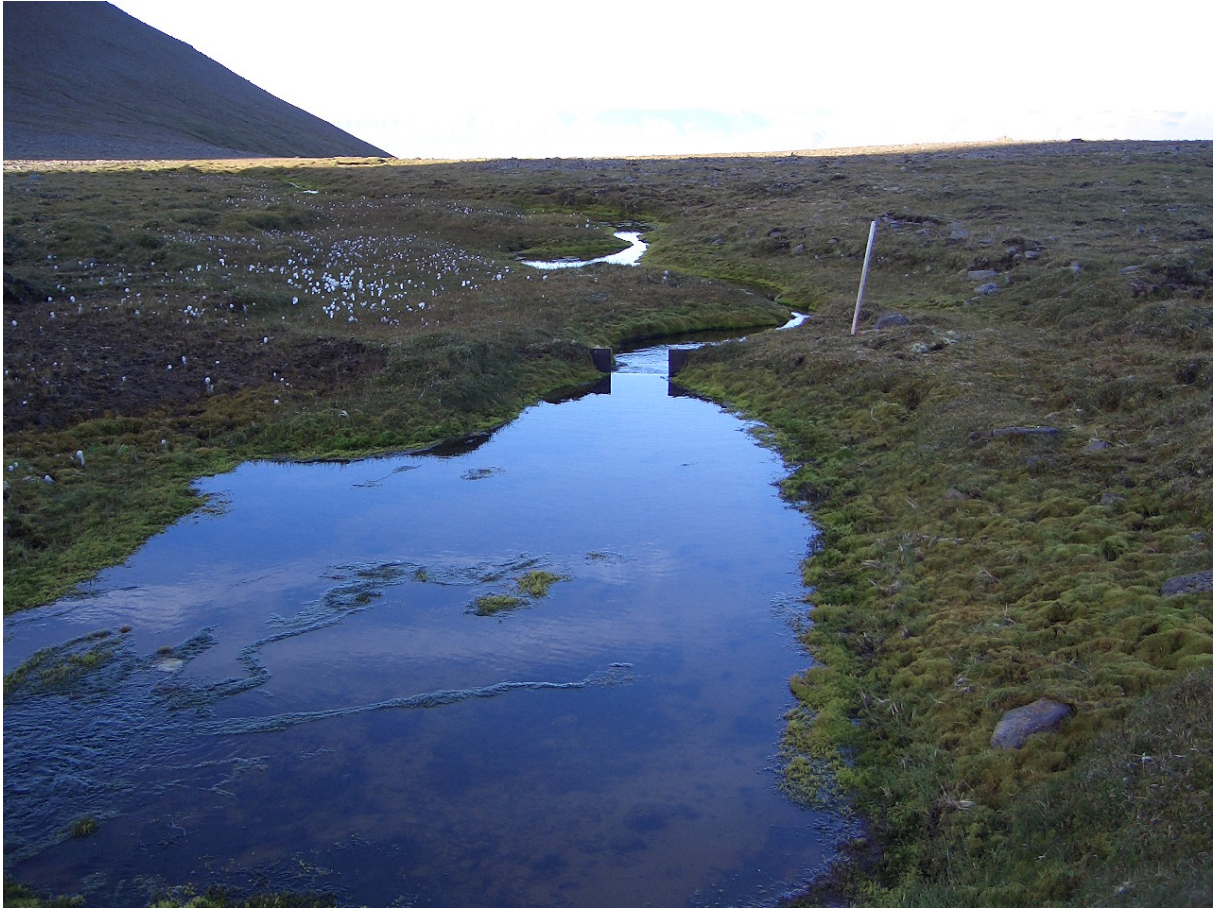
V3106 Stífla í Sólheimalæk efst, staðsetning : N 65° 35,084° W 19° 38,107 Yfirfall 50 cm breitt. Sama gerð og í Ytrilæk efst.
