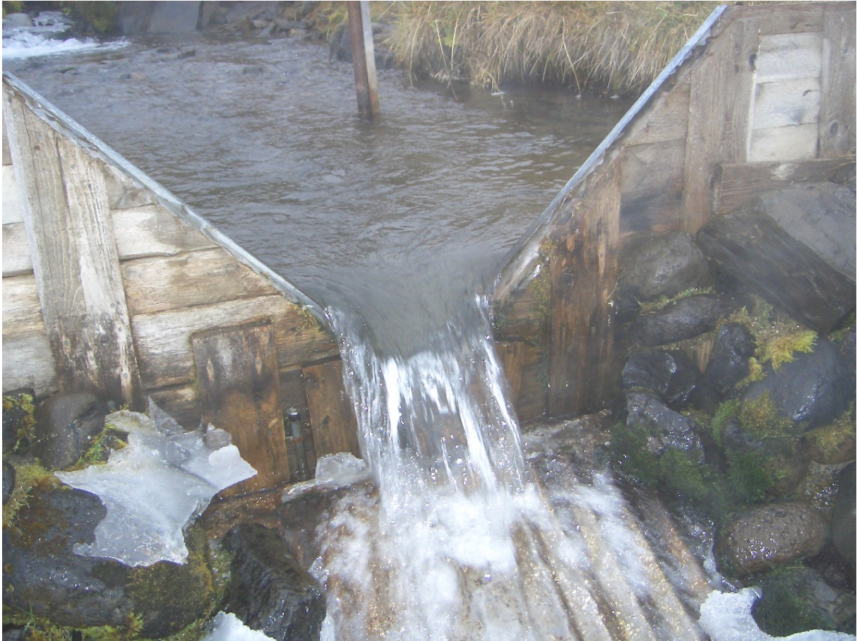
V3103 Ytrilækur uppi, stíflan gerð úr timbri og grjóti, og járnvinkill boltaður innan á stífluopið.
