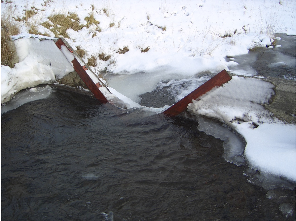
V2933 Eins og sést á myndinni er stíflan steipt, taldi það traustast vegna flóða.
