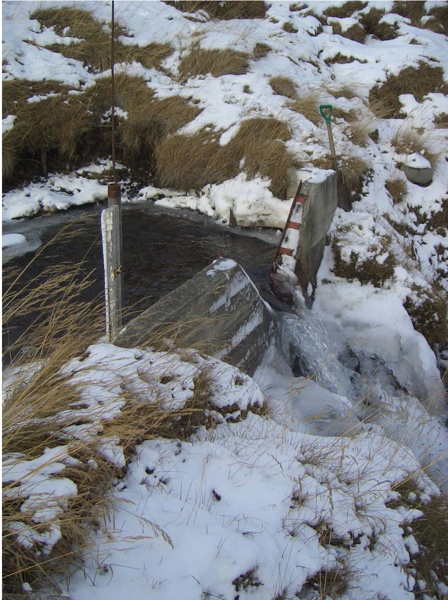
V2933 Flatjárn er boltað innan á stífluvegginn og loftar undir bununa fyrstu 7-10 cm en svo dettur hún niður á stífluskarðið.
