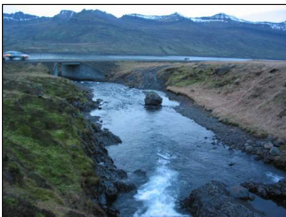
Mynd 7: Ofan brúar
