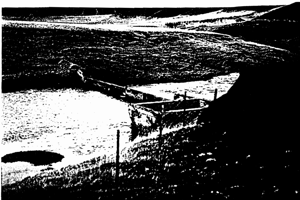
Ljósmynd 2. Horft til suðurs yfir stíflu frá 1952 neðan við Ketilhúshaga. Sandsteinshöfðinn er til hægri og ósamlímdi sandhjallinn sést handan ár á efri hluta myndarinnar.
